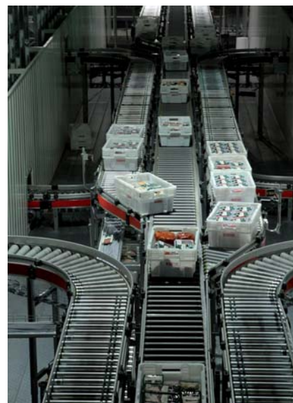
Op de 'central window conveyor' komen de uitslagbanen van alle twaalf commissioners bij elkaar. Door klantenbakken op het juiste moment in te schieten, wordt de juiste volgorde geformeerd.
